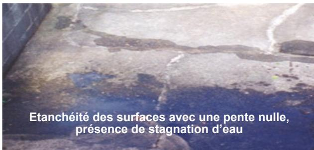
Étanchéité des surfaces avec une pente nulle, présence de stagnation d'eau
