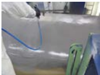
Application au pistolet Airless « Kremlin »
