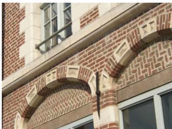
MURS EN BRIQUES
